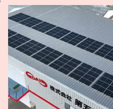
▲太陽光パネルの設置
